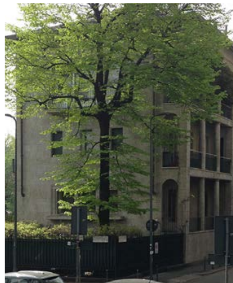
Villa Falk, realizzata da Mino Fiocchi in via Telesio.
